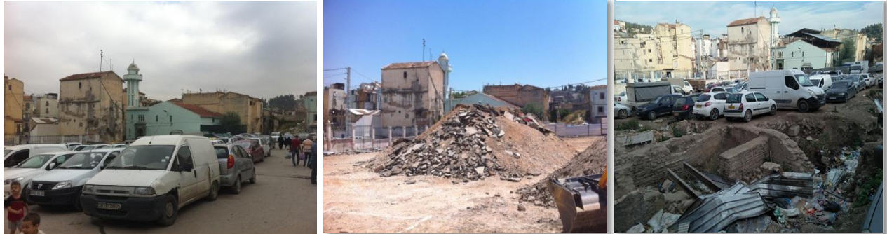
l'avancement de réhabilitation de la place TATACHE BELKACEM Source : Imane Fentazi
