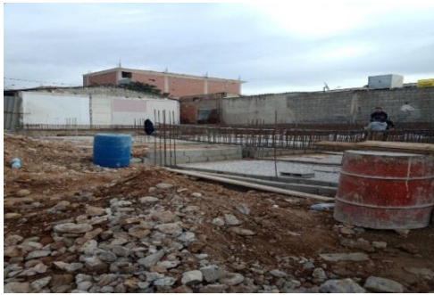
صورة 06: إعادة بناء شاليهات RHP
