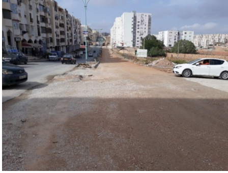
صورة رقم (04): تهيئة الطريق الرئيسي بالوحدة الجوارية 13
