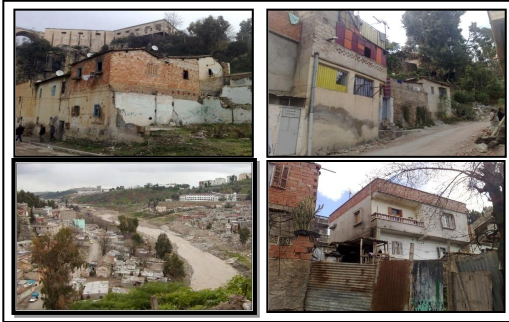
Images 14 : État des constructions du site « Bardo » avant la démolition, Constantine
