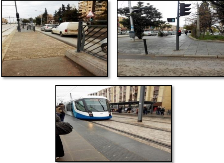
Photos 8, 9,10 : aménagement des allées piétonnes, aménagement des voies et intersections, intégration du tramway.
