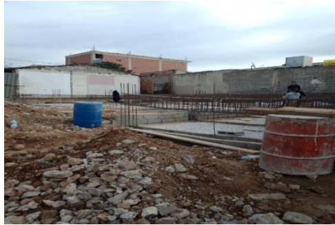
صورة 06: إعادة بناء شاليهات RHP
