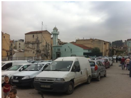
réhabilitation de la place
