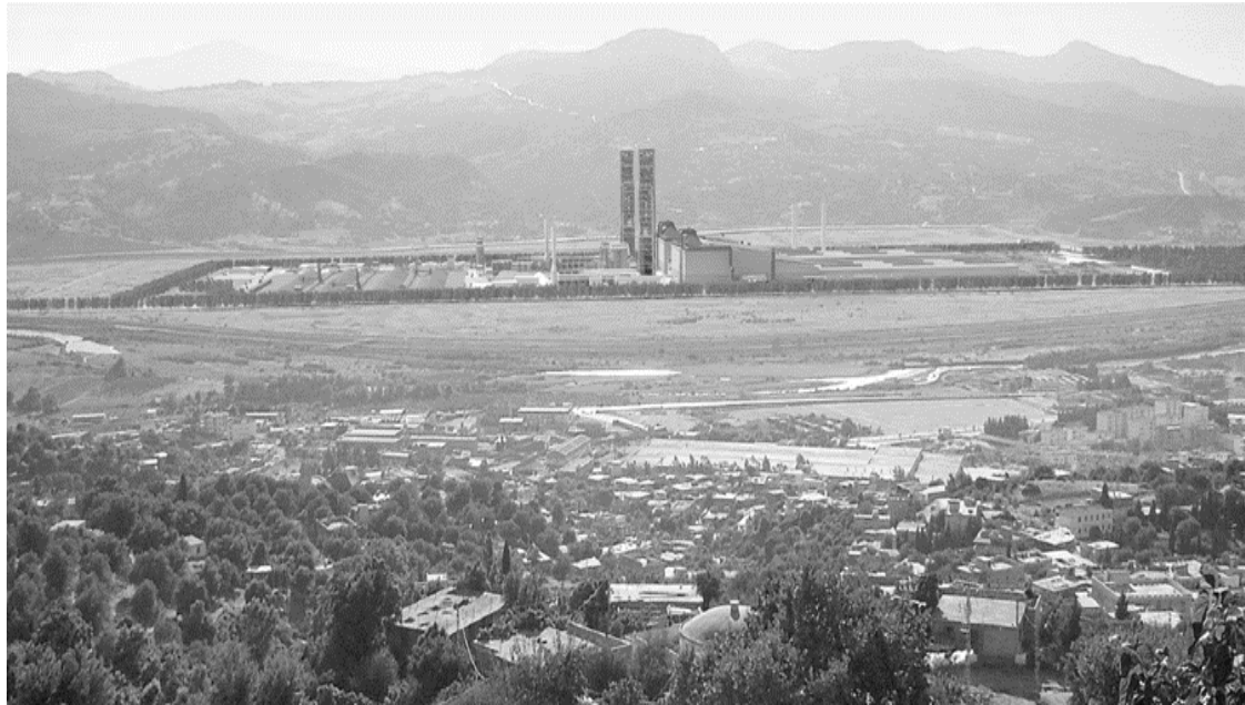
Figure 6: Vue générale du complexe sidérurgique de Ballara. Source : www.jjel.info.dz
